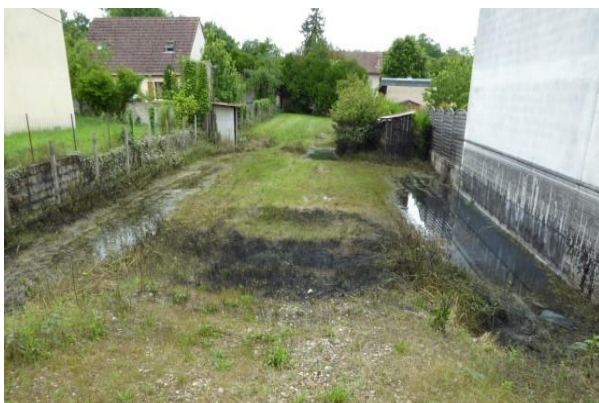
Contamination localisée dans une dépression, décapage superficiel du sol contaminé à la binette et évacuation
