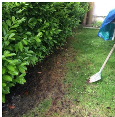
Contamination localisée dans une dépression, décapage superficiel du sol contaminé à la binette et évacuation
